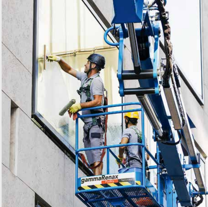
La pulizia delle facciate con skyworker richiede misure di sicurezza particolarmente severe.
